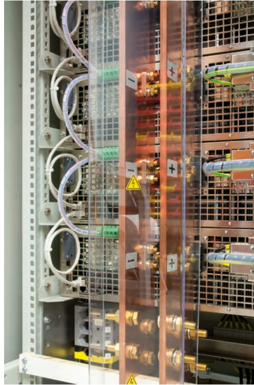
直流总线端子 / DC bus terminal
